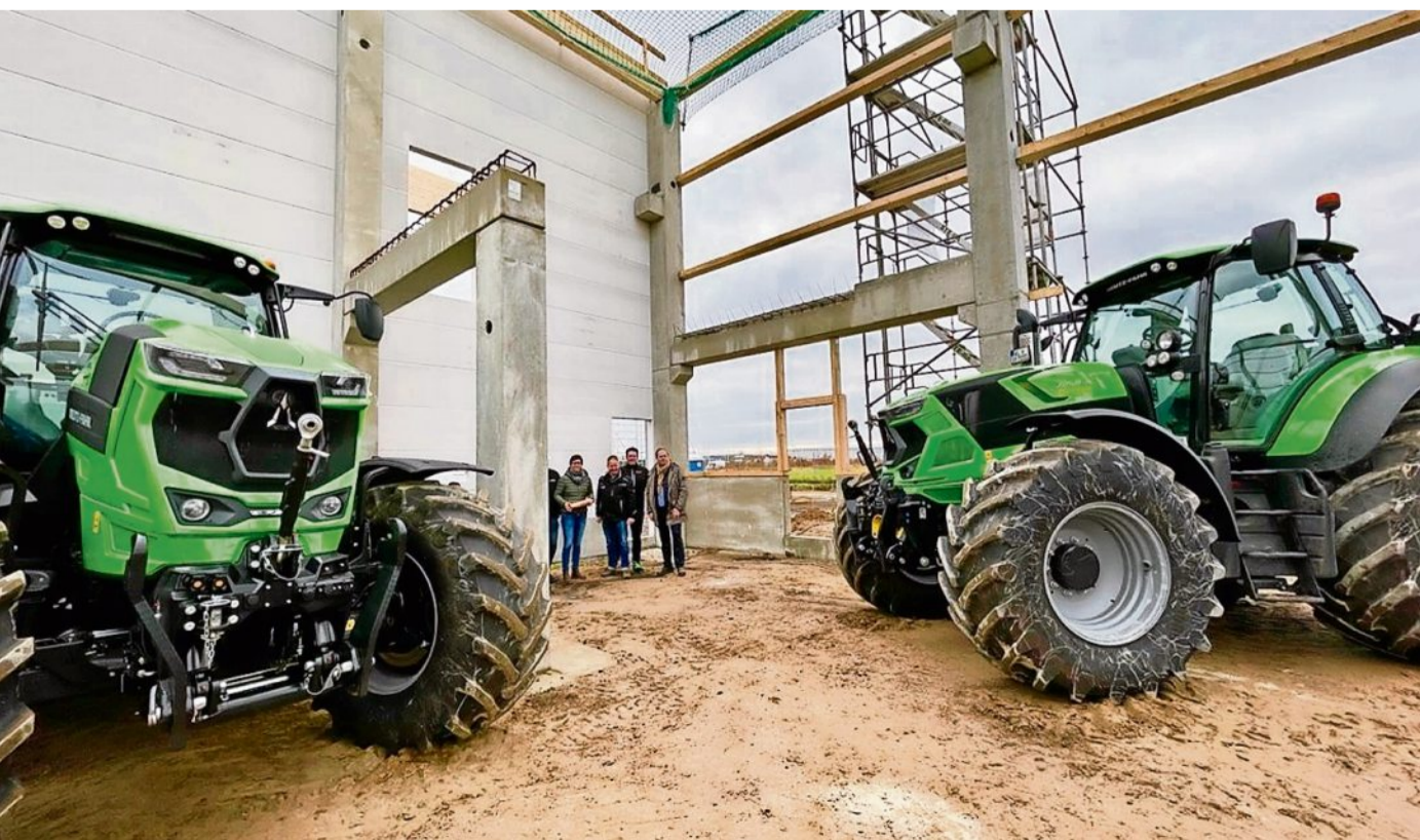
In Sottrum, direkt an der Autobahnausfahrt im Gewerbegebiet, ist die neue Betriebsstätte von Meyer Agrartechnik entstanden.
